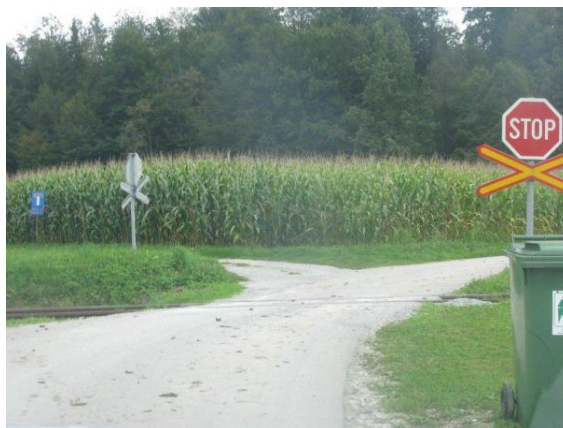
Slika 25: Nezavarovan prehod čez železniško progo na relaciji Šentvid–Bodrež.
